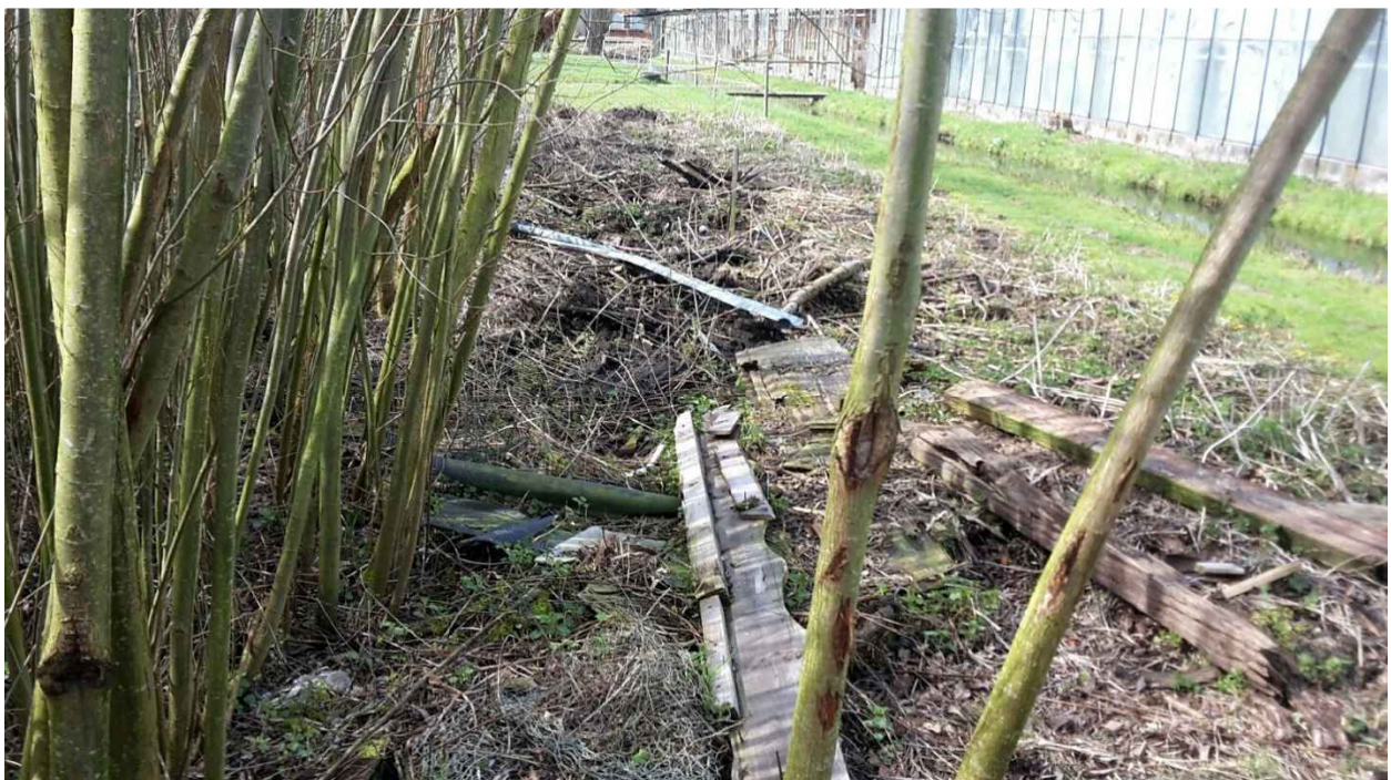
Foto 2: Asbestverdacht plaatmateriaal, gezien in westelijke richting.
