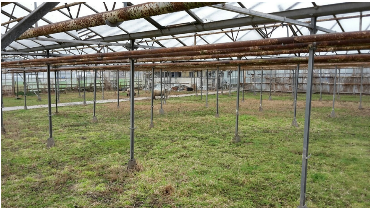
Foto 2: Kas, gezien in noordelijke richting
