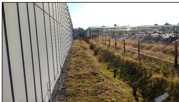
Foto 6: De strook aan de zuidkant van het projectgebied.
