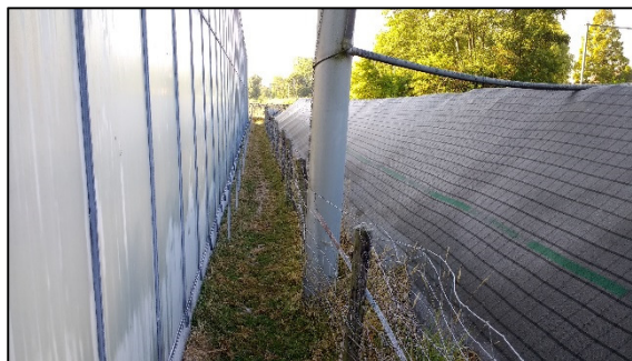
Foto 2: De ruimte tussen de kas en het waterbassin.
