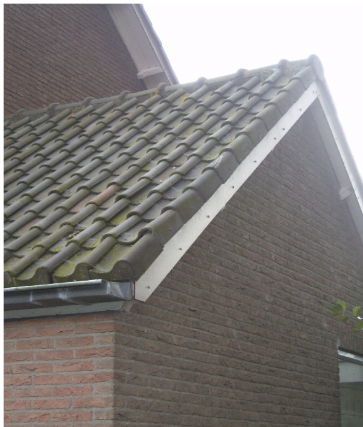
Huis aan de Tilanussingel met dakpannen en houten betimmering
