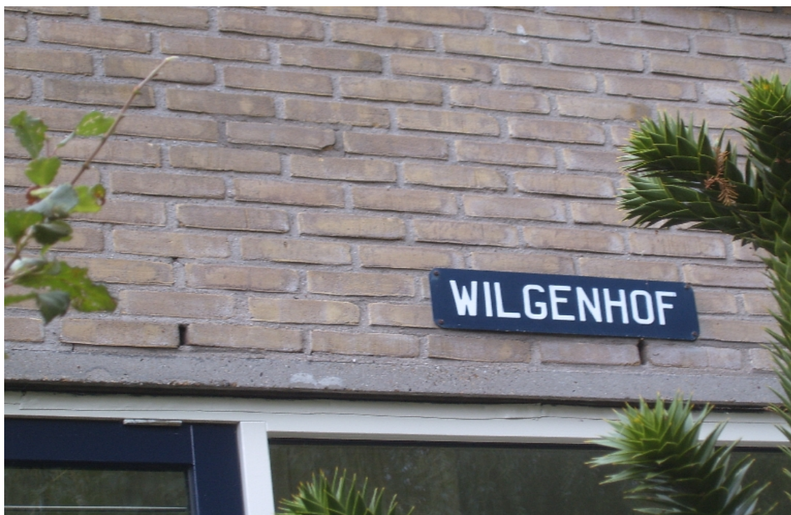
Foto van een woning aan de Wilgenhof met een spouwmuren met open stootvoegen
