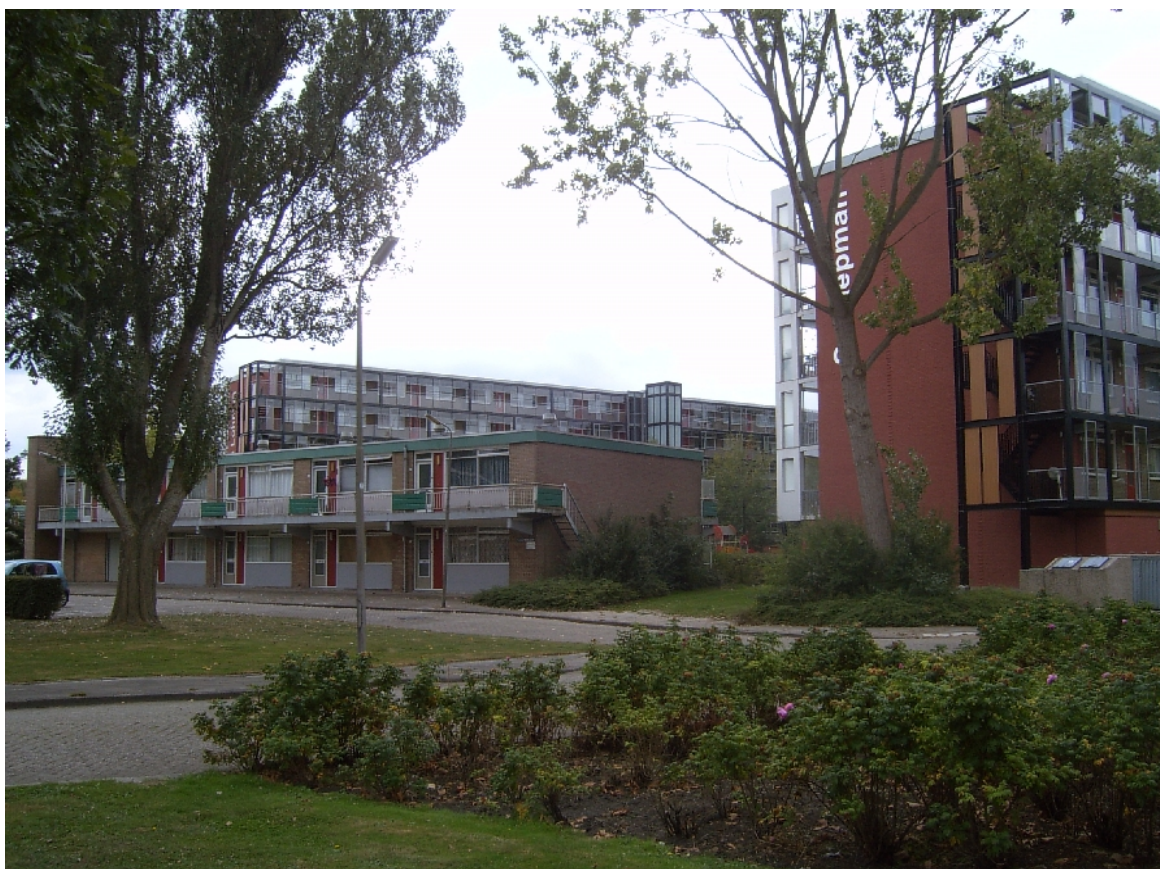
Impressie foto van de 2- en 6- laagse flatgebouwen bij de Thorbeckelaan
