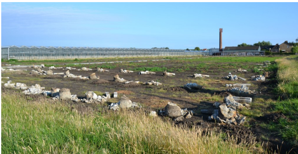
Sloop kas Berkelseweg 26 in uitvoering
