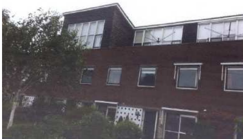
Eerder gerealiseerde dakopbouw Duikersloot
