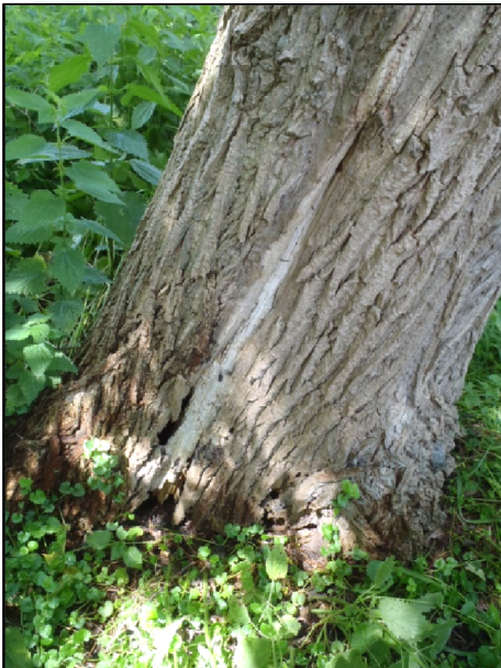
Door rotting is bij deze boom een verhoogd breukrisico ontstaan.
