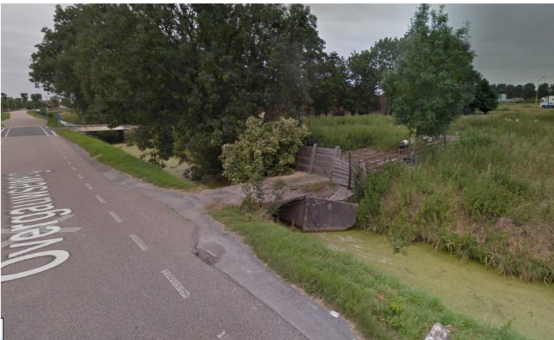
Figuur 13: Brug (K22) in watergang langs Overgauwseweg (deze wordt verwijderd)
