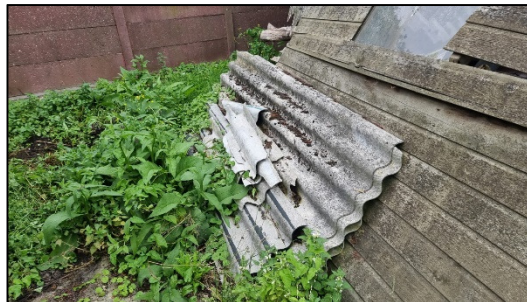
Foto 2: Schuur voorafgaand aan de sloop
