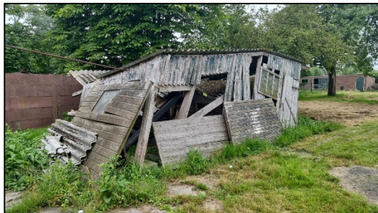
Foto 1: Schuur voorafgaand aan de sloop
