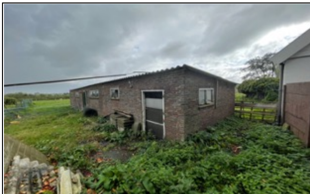
Foto 1: Achterliggende stal-schuur gemetselde muren
