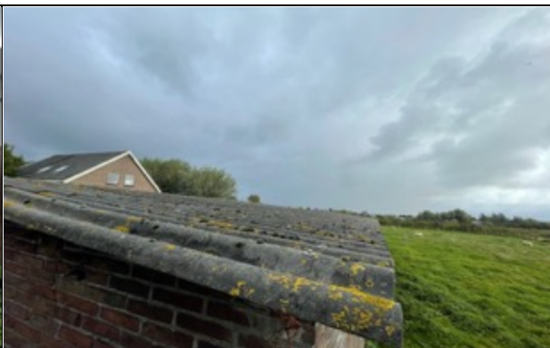
Foto 2: Dak stal-schuur met golfplaten
