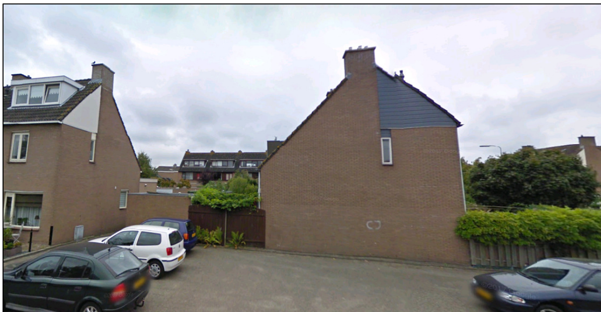
Afbeelding 7: Een voorbeeld van een gebouw die een geschikte spouwmuur heeft
