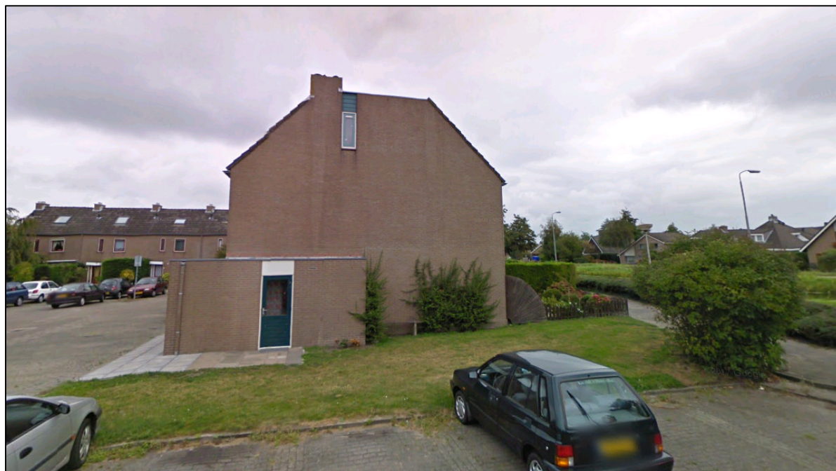
Afbeelding 4: Een voorbeeld van een gebouw die een geschikte spouwmuur heeft en geschikt is voor het plaatsen platte vleermuiskasten binnen 200 meter van het projectgebied.
