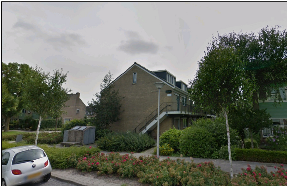
Afbeelding 6: Een voorbeeld van een gebouw die een geschikte spouwmuur heeft
