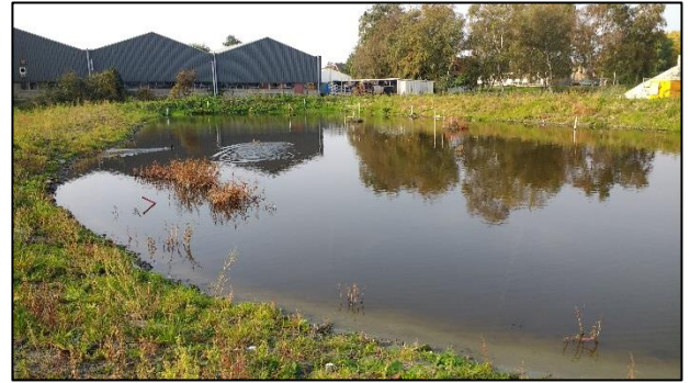
Foto 2: infiltratievijver braakliggend terrein
