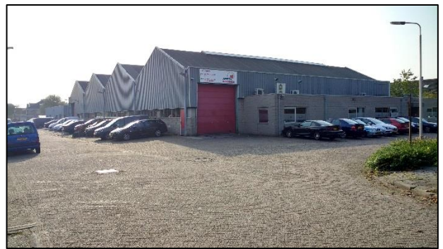
Foto 4: Aweta-bedrijfshal met kantooraanbouw
