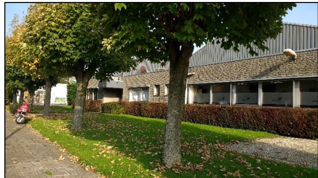
Foto 6: esdoorns met erachter Aweta-bedrijfshal met aanbouw
