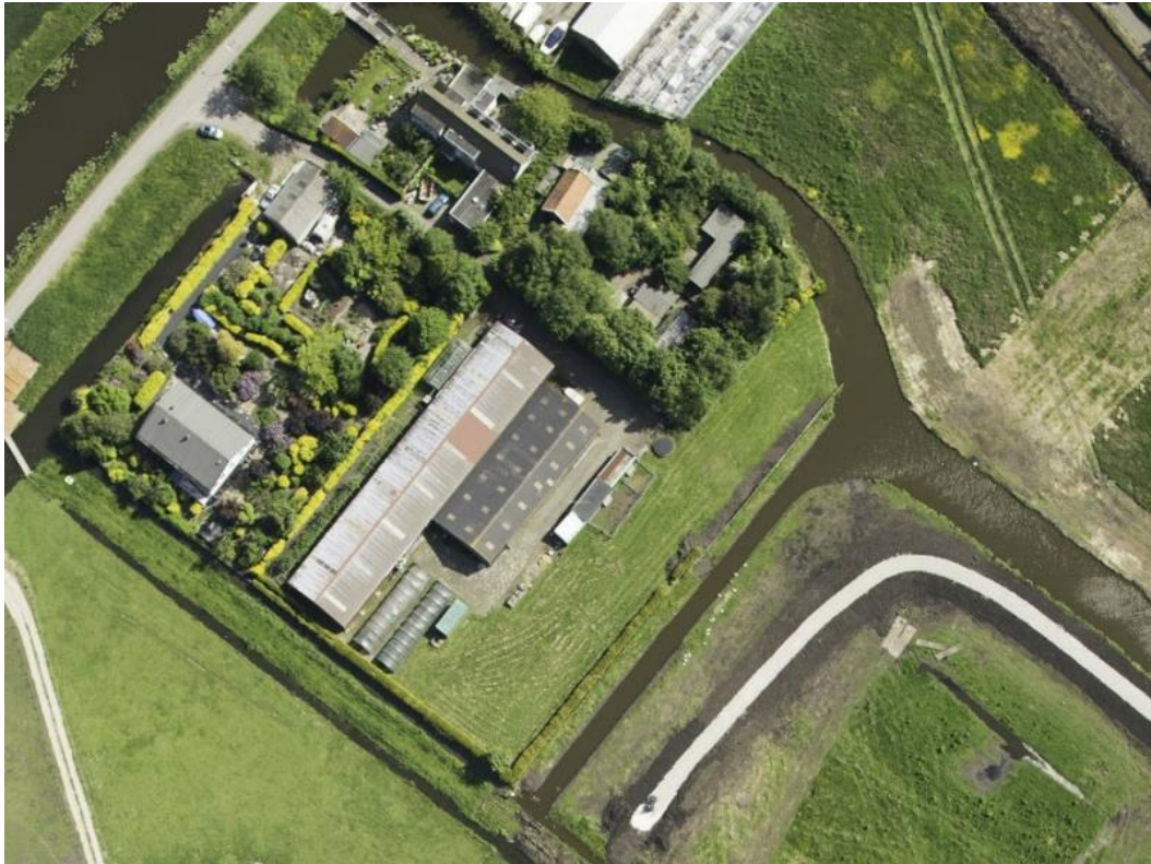
Luchtfoto perceel nabij Polderweg 14
