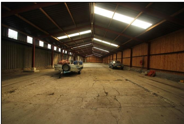
Foto 5: Binnenzijde oostelijke schuur
