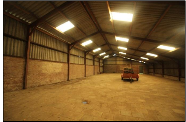
Foto 2: Binnenzijde westelijke schuur
