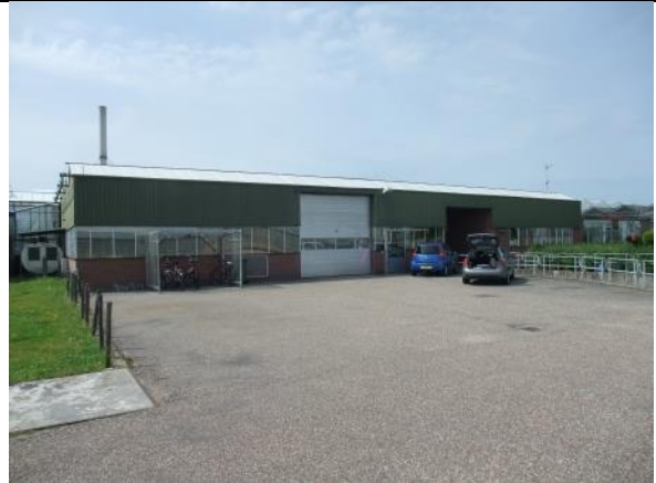
Links ketelruimte, rechts verwerkingsruimte
