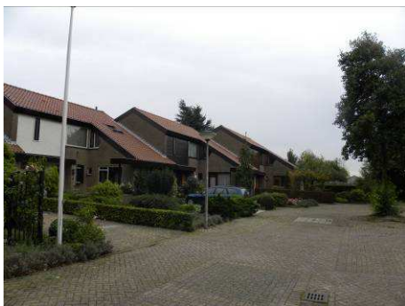
Geschakelde woningen Dokter W. van der Horstlaan (Bron: Croonen Adviseurs, 2011)
