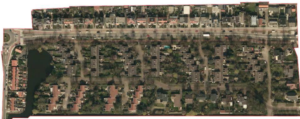
Luchtfoto plangebied (Bron: gemeente Pijnacker-Nootdorp, 2011)
