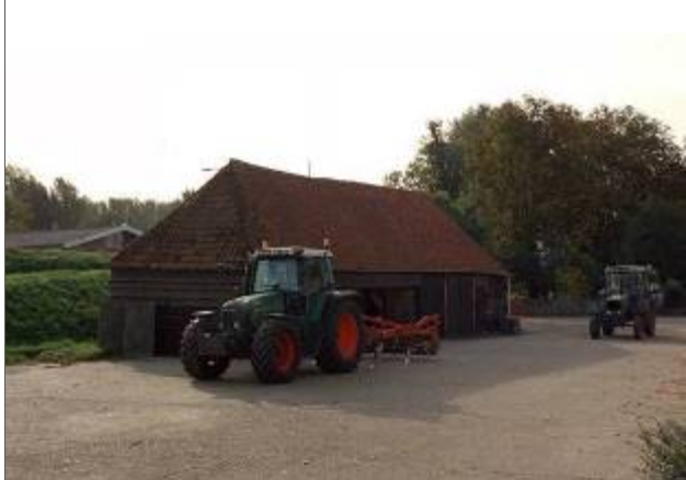
Wagenschuur met glintdeuren.
