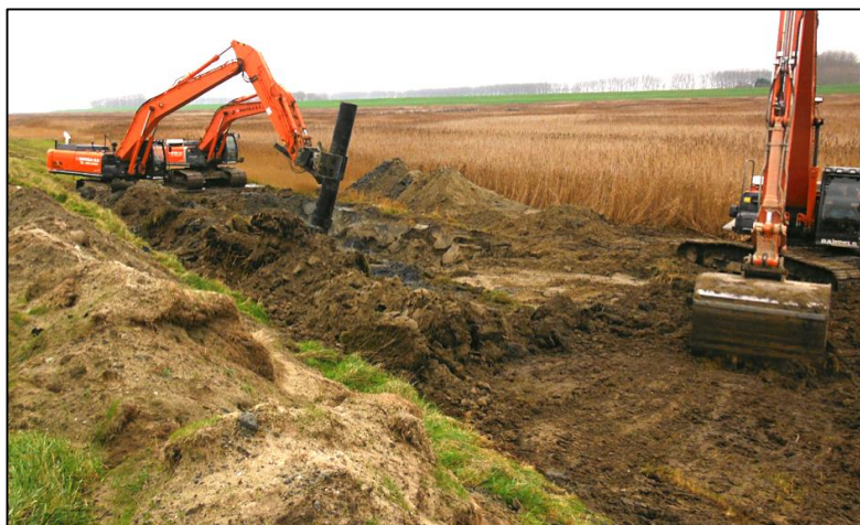
Figuur 2.4 Voorbeeld van de wijze waarop de oude transportleiding in Scheelhoek zal worden verwijderd (foto: Evides).
