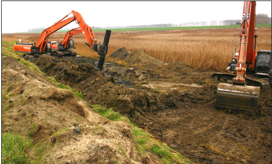
Figuur 2.11 Voorbeeld van de wijze waarop de oude transportleiding in Scheelhoek wordt verwijderd (foto: Evides).
