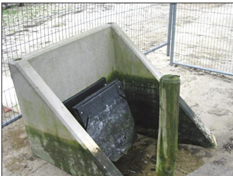
Figuur 2.12 Een rattenklep.
