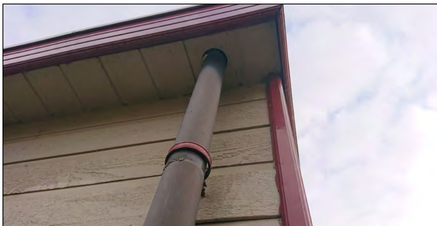
Figuur: in de recreatiewoningen zijn onder andere doorlopende openingen achter de regenpijp aangetroffen, waarachter verblijfplaatsen voor vleermuizen aanwezig kunnen zijn.
