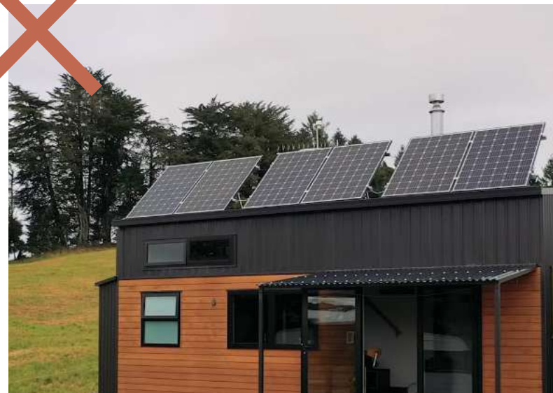
Zonnepanelen op platte daken worden vlak geplaatst, niet onder een steile hoek zoals op deze referentie. Bron: treehugger.com
