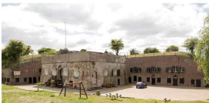
De geschutstoren vanuit het noordoosten. De toren is een geschutstoren uit de Franse tijd (tour modèle ca 1811) met een afwijkende rechthoekige plattegrond. De afmetingen op straatniveau zijn ca 16,5 x 22,5 m. Met uitzondering van de deuropening zijn de overige grotere openingen later ingebroken.
