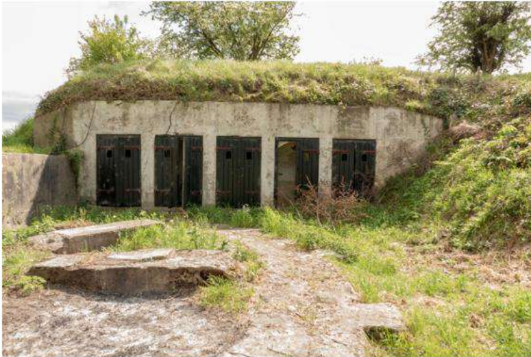
Restant van een geschutsopstelling, gericht op het oosten, naast gebouw N
