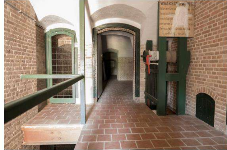
Handbediende installatie voor de munitielift, links een ingang voor de bediening van de lantaarns buiten de opslagruimtes
