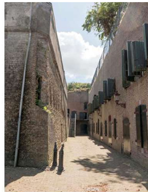
Westgevel van de toren en oostgevel van het westelijk deel van de kazerne
