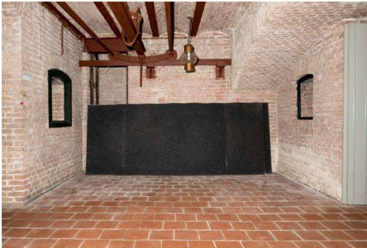
Transportinrichting voor munitie, aansluitend op munitielift
