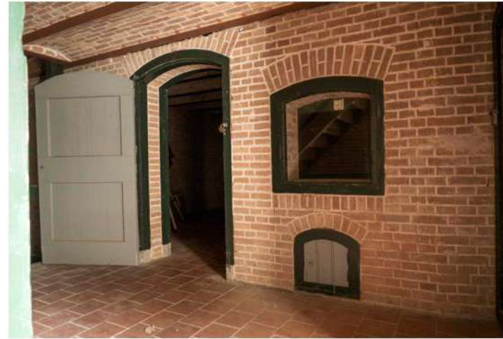
Ingang van een opslagkamer in het kruithuis
