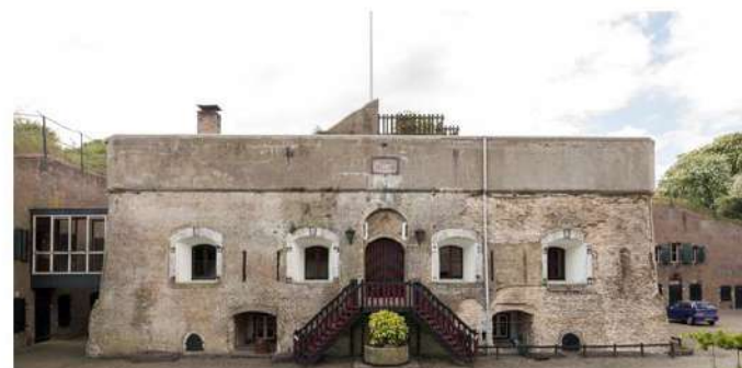
De geschutstoren vanuit het oosten. Boven de deur zijn de openingen te zien voor het doorvoeren van de kettingen van de vroegere ophaalbrug. Bij de wijziging in de jaren 80 van de negentiende eeuw zijn de uitbouwen van de tour modèle verwijderd en het dak met de voormalige geschutopstelling is voorzien van een aanaarding.
