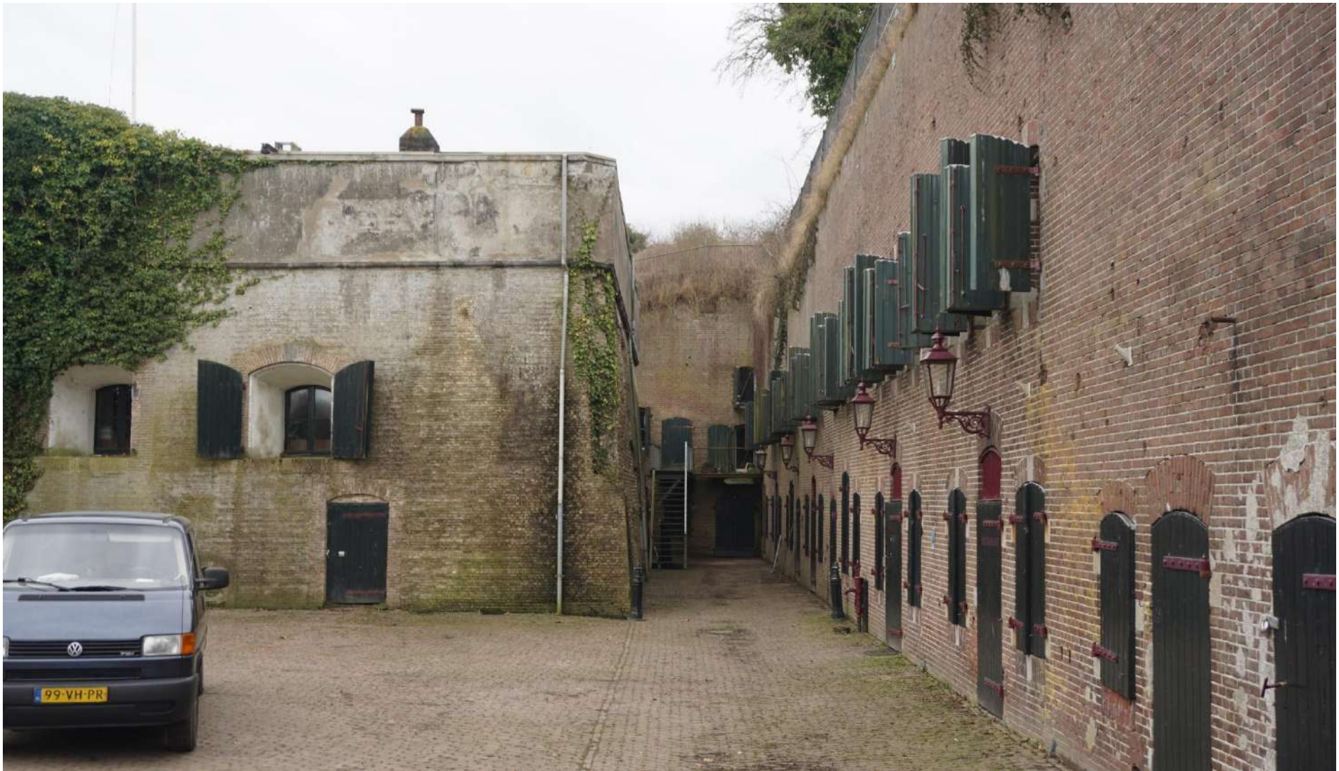
Toren, langsgevel kazerneleugel en centraal de entree van het kruithuis in de hoek,
