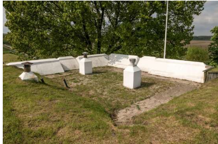
Afb 9 Geschutopstelplaats op het dak van de geschutstoren van Fort De Hel
