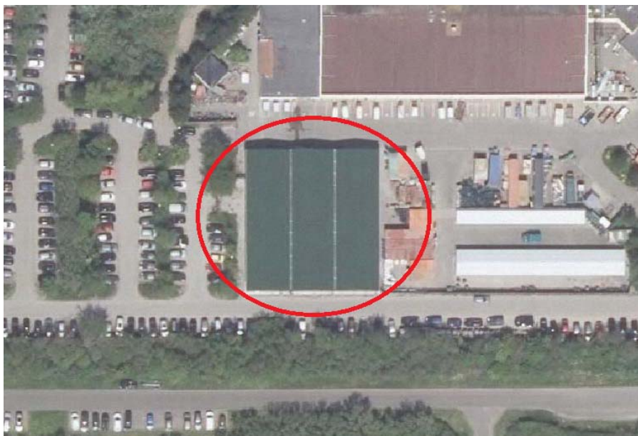
Figuur 5 De loods is gerealiseerd met een tijdelijke vergunning
