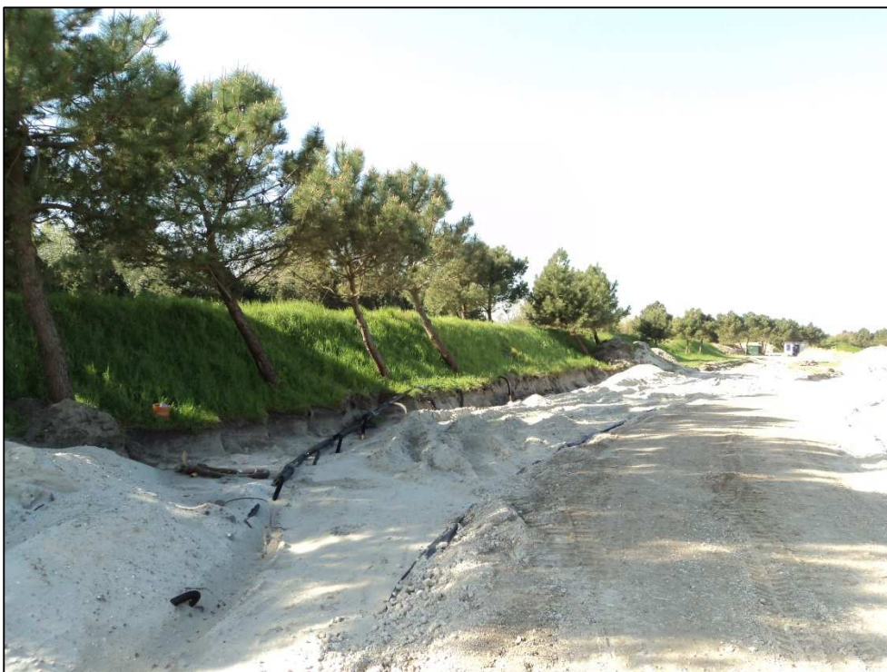
Na aanvulling saneringsput
