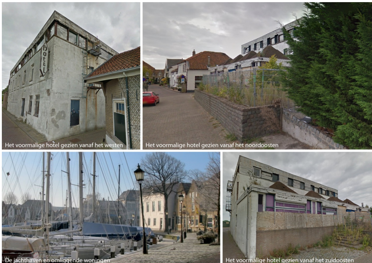
Afbeelding 2.1: de bestaande situatie van het hotel en haar omgeving voor de sloop van het hotel
