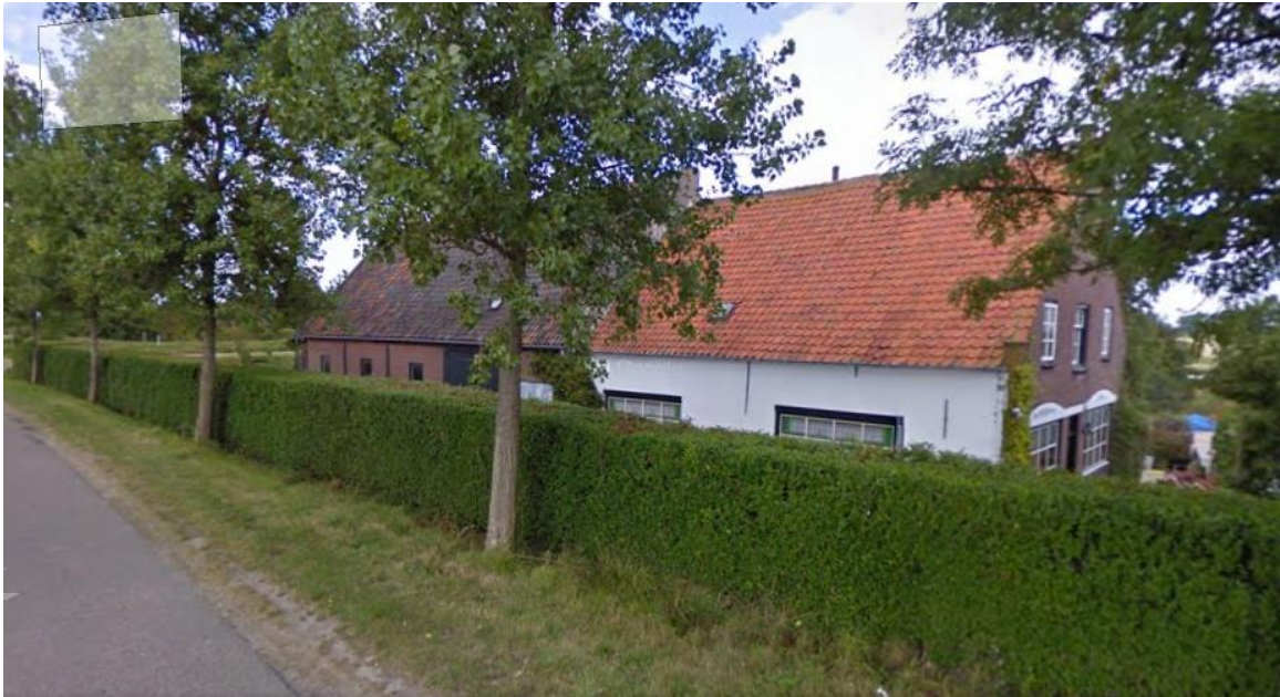
Figuur 1.2 foto voorzijde woning en schuur Peuterdijk 54
