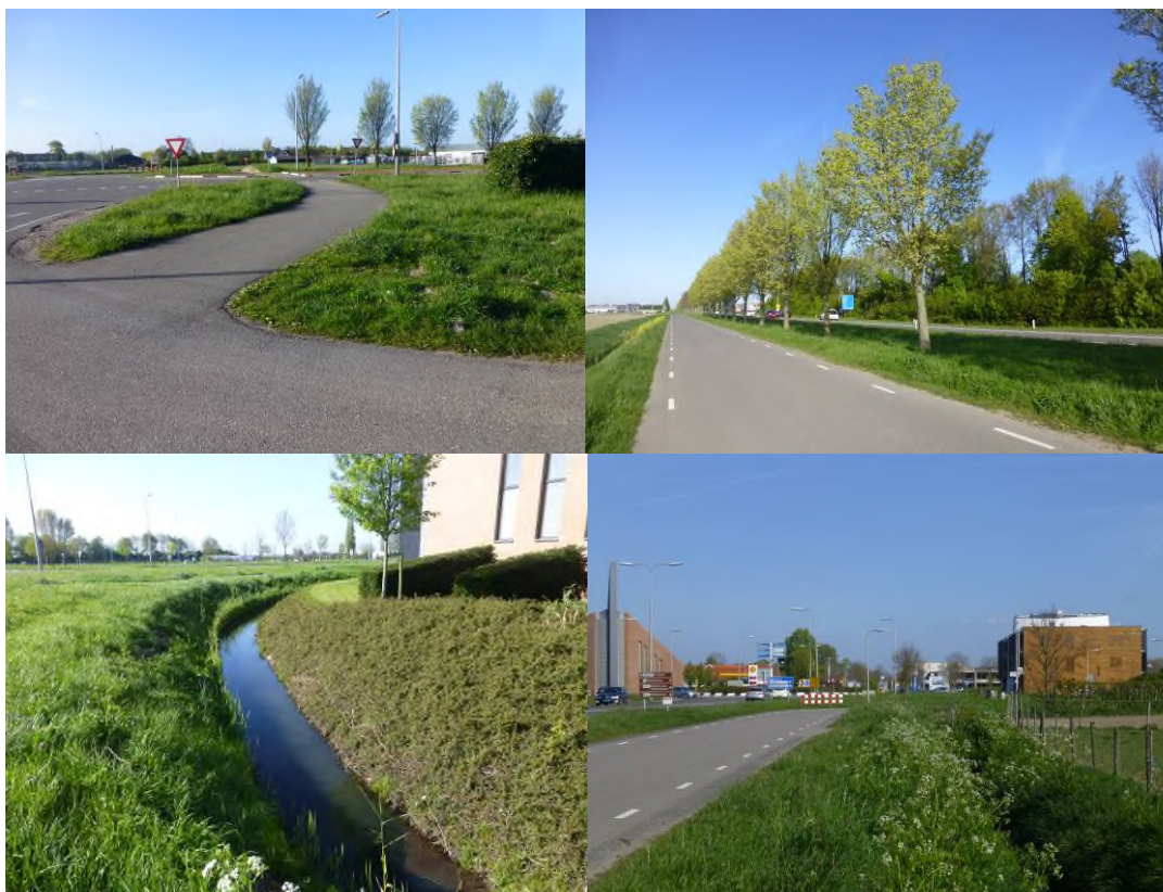
Afbeelding 5.1. Impressie locatie ten zuiden van Middelharnis. Linksboven de locatie waar de bermen in beslag worden genomen door de verbeterde fietsaansluiting; rechtsboven de locatie van bomen die worden gerooid ten behoeve van de passeerplaats en onder de watergangen en bermen rondom de bestaande rotonde.
