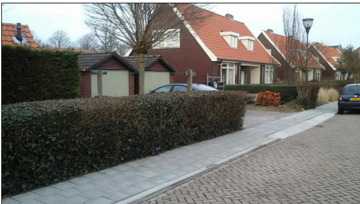
Afbeelding 3. Foto's bestaande situatie
