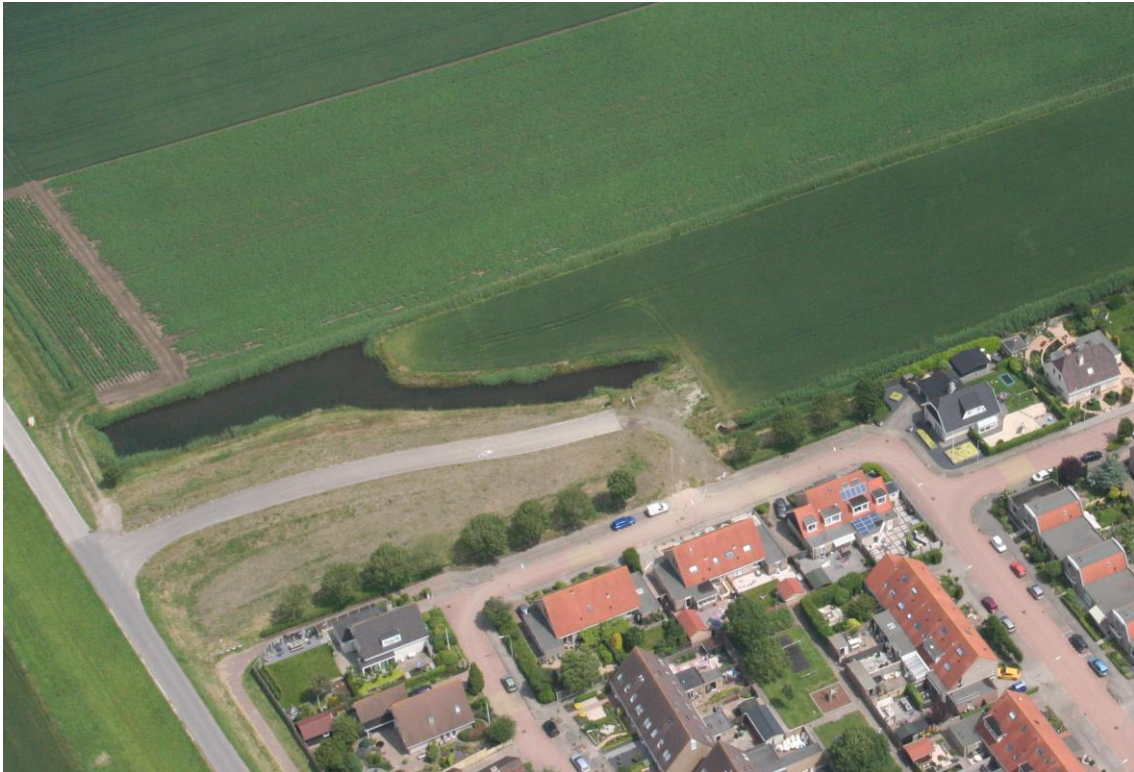
Afbeelding: Luchtfoto van aangelegde ontsluiting en waterberging
