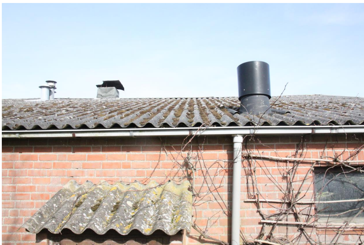
Foto 2: Onder de bitumen dakplaten is nauwelijks plek voor huismussen om te nesten. Er zijn ook geen nesten van eerdere jaren aangetroffen.
