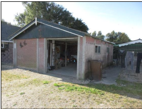
Foto 1: Schuur naast woonhuis in plangebied
