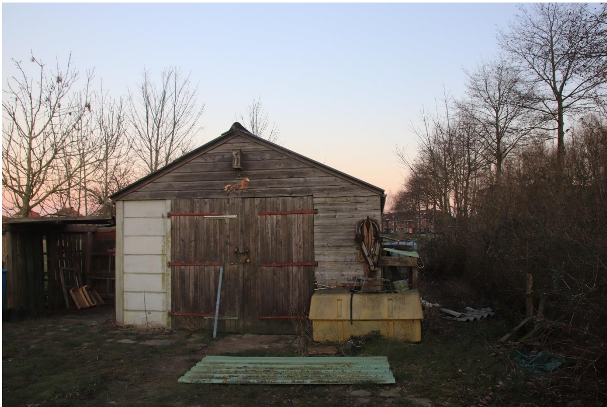
Foto 1: De houten schuur op de locatie wordt verwijderd/gesloopt
