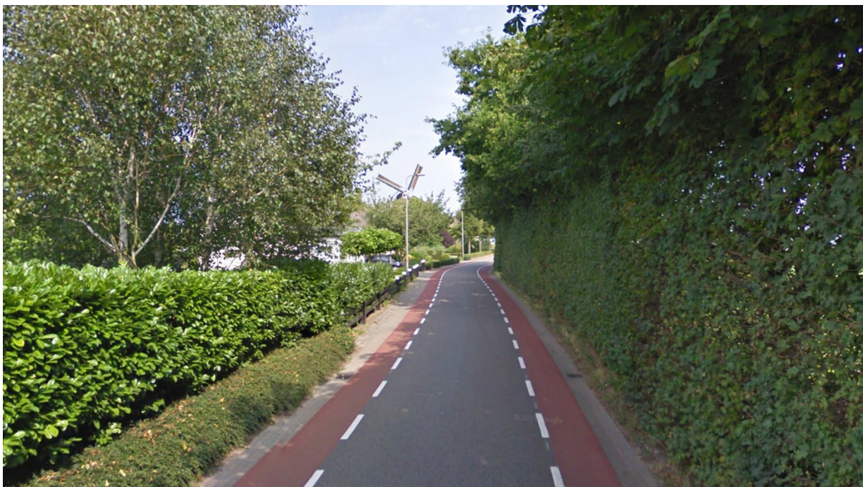
Situatie ter plaatse Molenweg 19/21.
