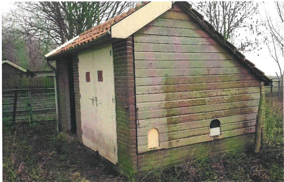
Figuur 5 De te slopen geitenshuur.
