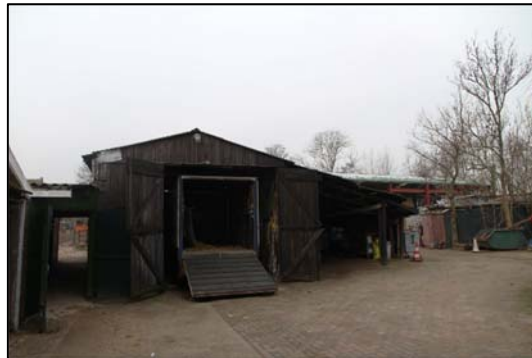
Foto 4. De te slopen schuur vanaf het oosten gezien. De muur van de te slopen schuur blijft behouden aan de linkerkant
