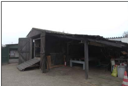
Foto 3. De te slopen schuur vanuit noordoostkant gezien
