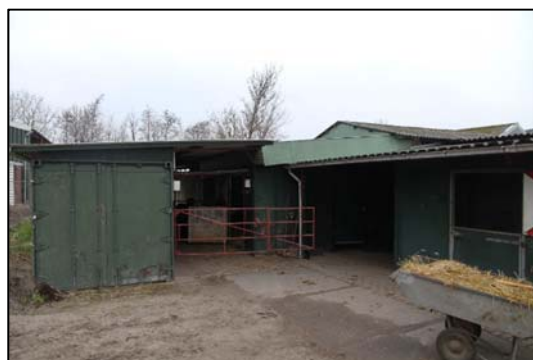
Foto 5. De te slopen schuur en container vanuit noordoostkant gezien. Het gebouw uiterst rechts blijft behouden
