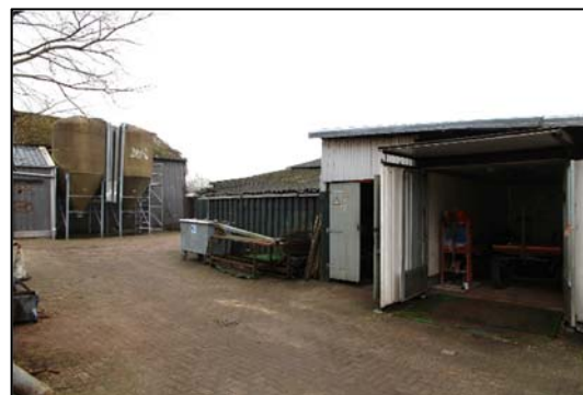
Foto 2. De te slopen schuur/container vanuit noorden gezien
