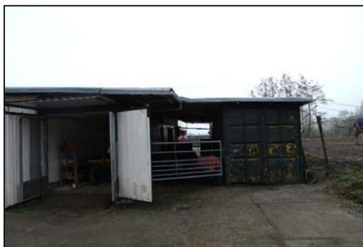
Foto 1. De te slopen schuur/container vanuit noorden gezien
