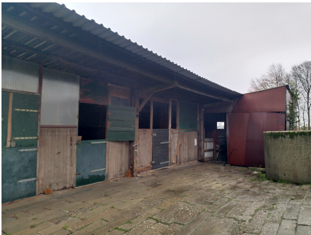
De opstal aan de zuidkant van het plangebied met schuur en ponybox. Foto: M. de Vries | Ecoresult B.V.
