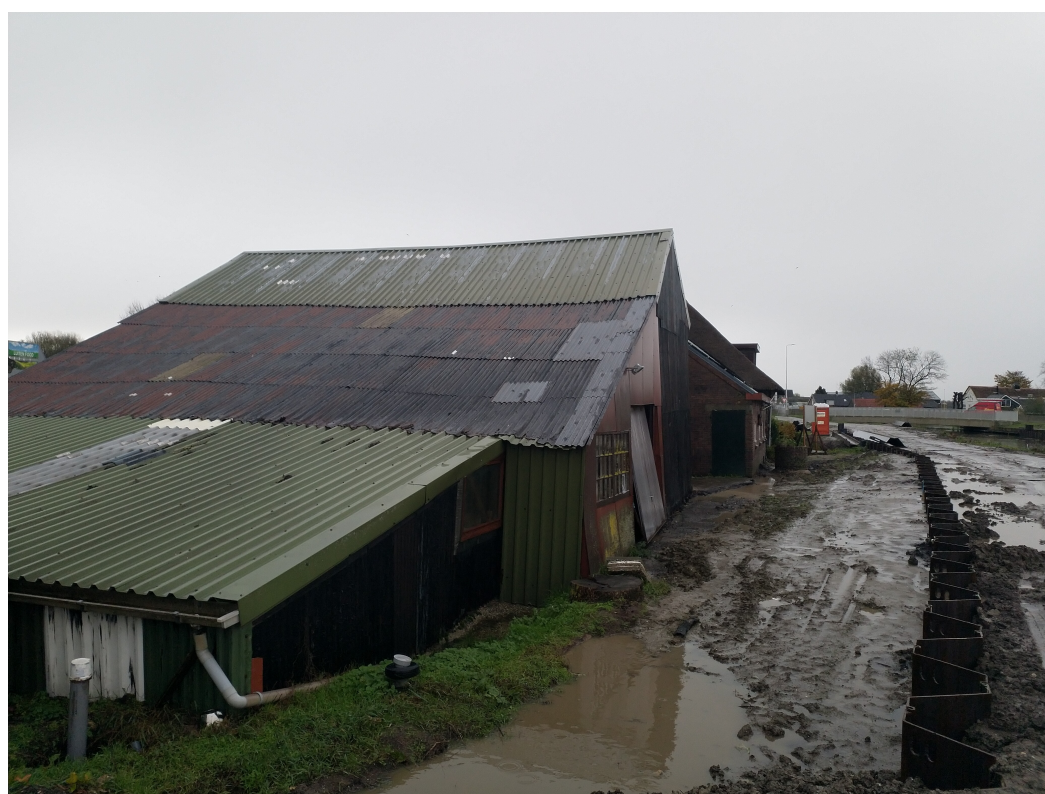
De opstal centraal gelegen in het plangebied kijkend richting het oosten. Foto: M. de Vries | Ecoresult B.V.
