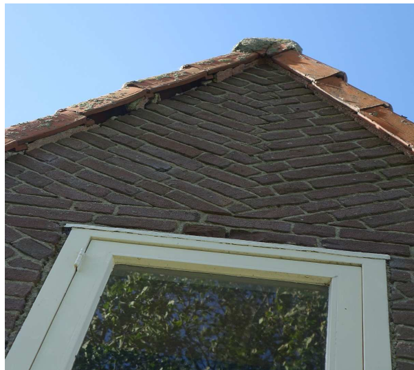
Figuur 4. Ontbrekend metselwerk aan de voor- en achtergevel van het bijgebouw, geschikt als verblijfplaats voor vleermuizen.
