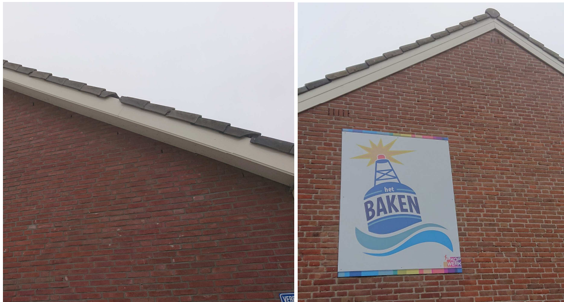
Figuur 7. Gevels met open stootvoegen en ventilatiestenen aan basisschool Het Baken
