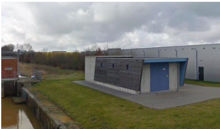
Afbeelding 1: De onderzoekslocatie, (linksachter) naast het bestaande regelstation.
