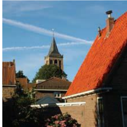
Rode dakpannen langs het lint voor een dorps karakter
