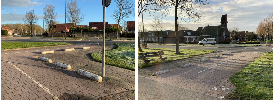
Afbeelding 13 en 14. Biggenruggen ter hoogte van de rotonde Westerterpweg – Brink
