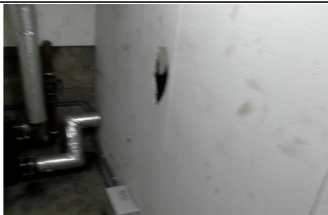
FOTO 4 | Plaatmateriaal niet asbesthoudend
