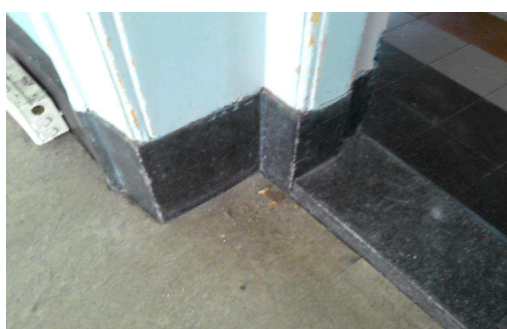
Foto 17: Drempels en plinten van hardsteen.
