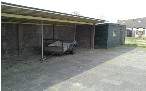
Foto 12: Fietsenstalling en schuurtje
