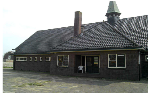
Foto 11: Torentje gedekt met koper. 1 schoorsteen
