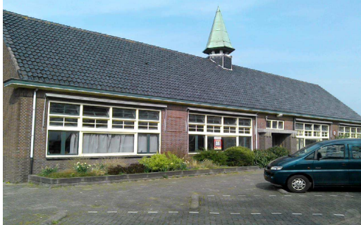
Foto 8: School opgetrokken uit metselwerk en met dakpannen gedekt.
