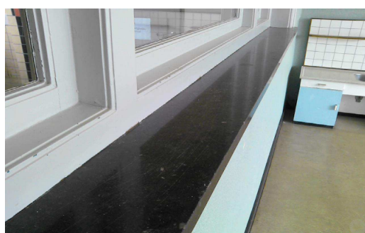
Foto 16: Vensterbank van hardsteen
