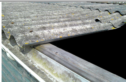
FOTO 1 | Niet asbesthoudende golfplaten schuur
