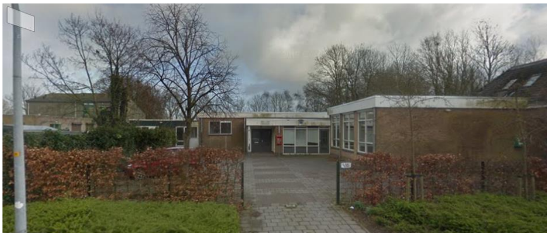
Aangezicht voormalige schoollocatie
