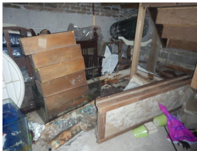
inspectie kruipruimte onder podium
