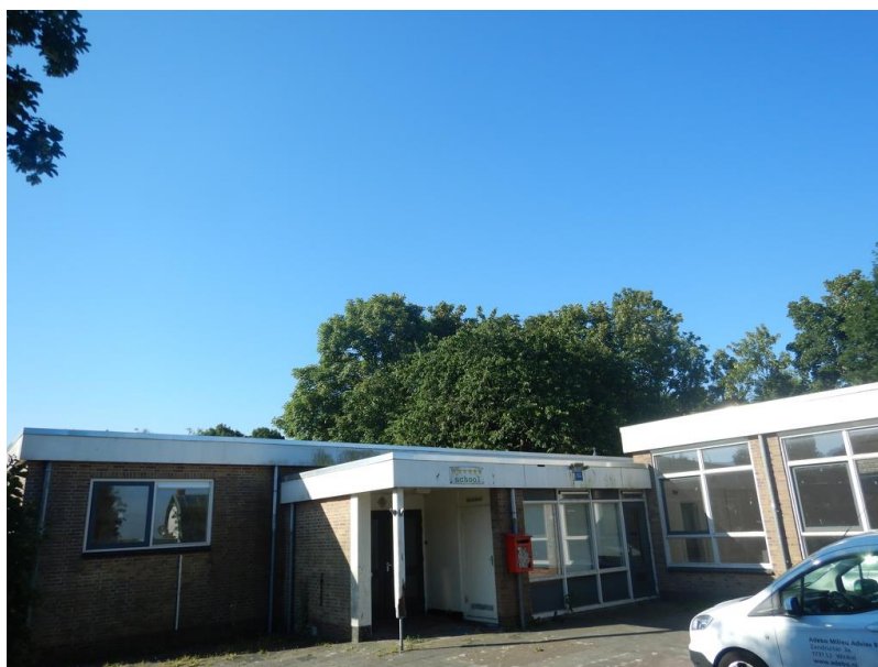
Het voormalige schoolgebouw aan de Dorpsstraat 38 te Oude Niedorp
