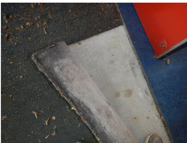
inspectie onder tapijt
