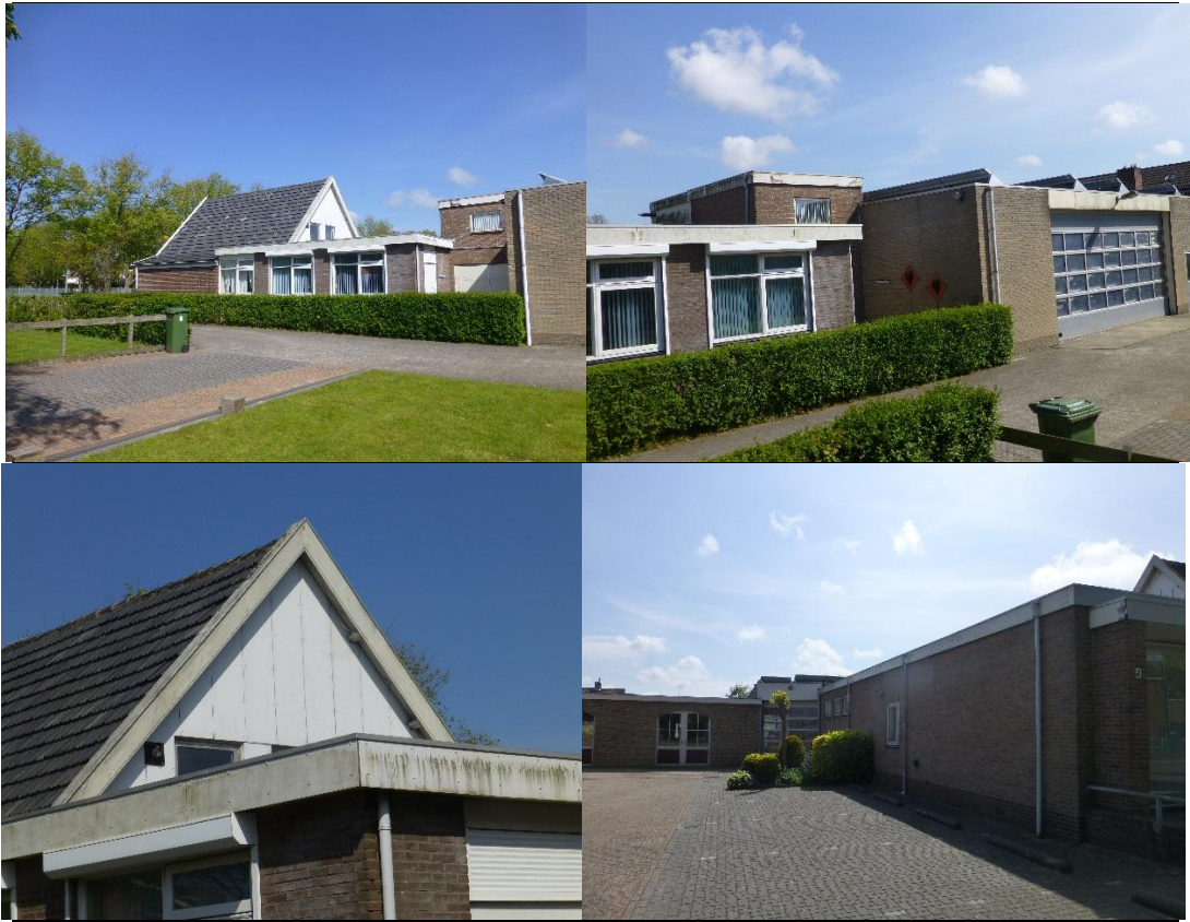
Figuur 5.1. Impressie bebouwing in het plangebied.
