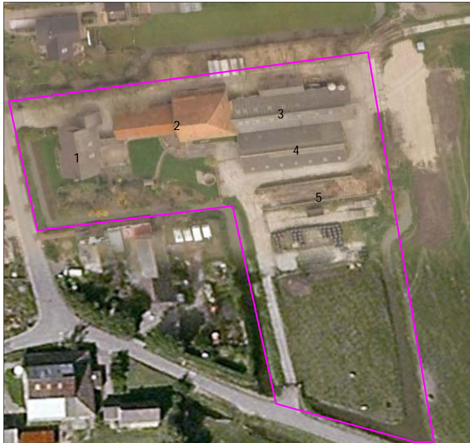
Figuur 2. Globaal overzicht plangebied (roze omkaderd) met daarin aangegeven: het woonhuis (1), oude schuren (2), koeienstal (3), schuur met goederen (4) en sleufsilos (5)
