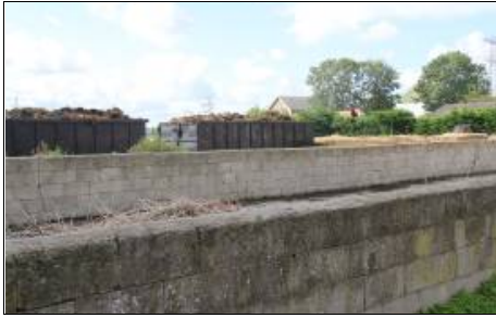
Sleufsilos en mestcontainers
