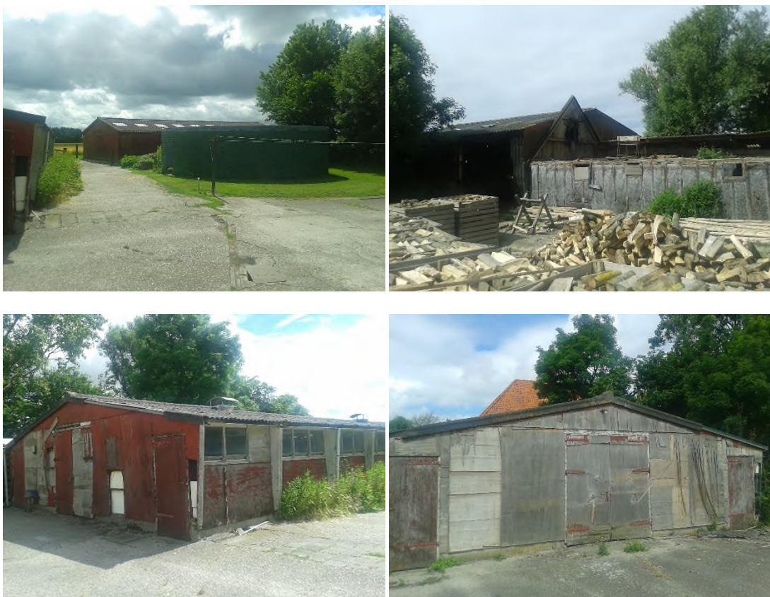
Figuur 33 Bestaande bebouwing locatie Boermansweg 27
