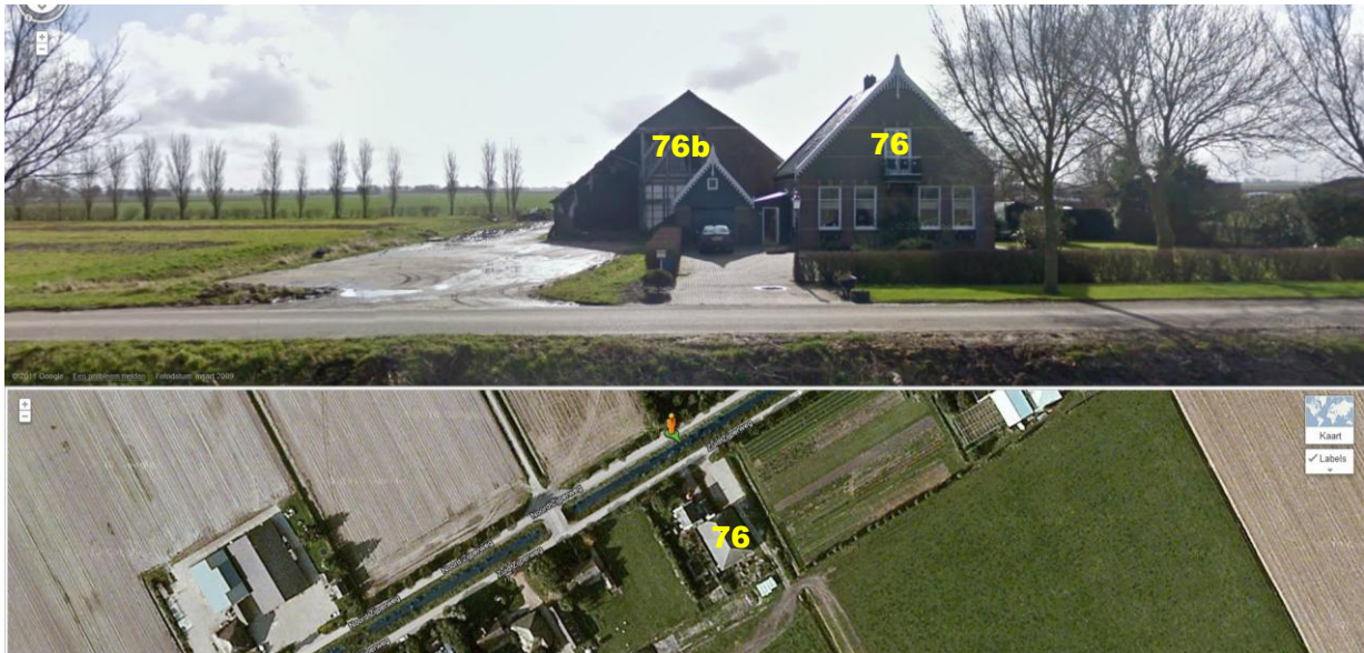
Afbeelding 5. Zuid Zijperweg 76/76b, woning met voormalige bedrijfsbebouwing (streetview)
