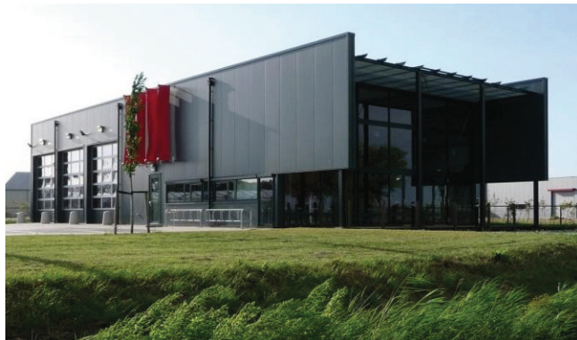
Bestaande brandweerkazerne Menaam. Het nieuwe representatieve bedrijfsgebouw dient hier in bouwvorm en kleur- en materiaalgebruik bij aan te sluiten.
