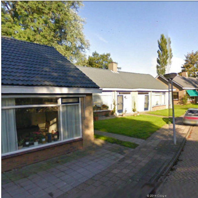
Bestaande bebouwing herontwikkelingslocatie 1 (Google Earth)
